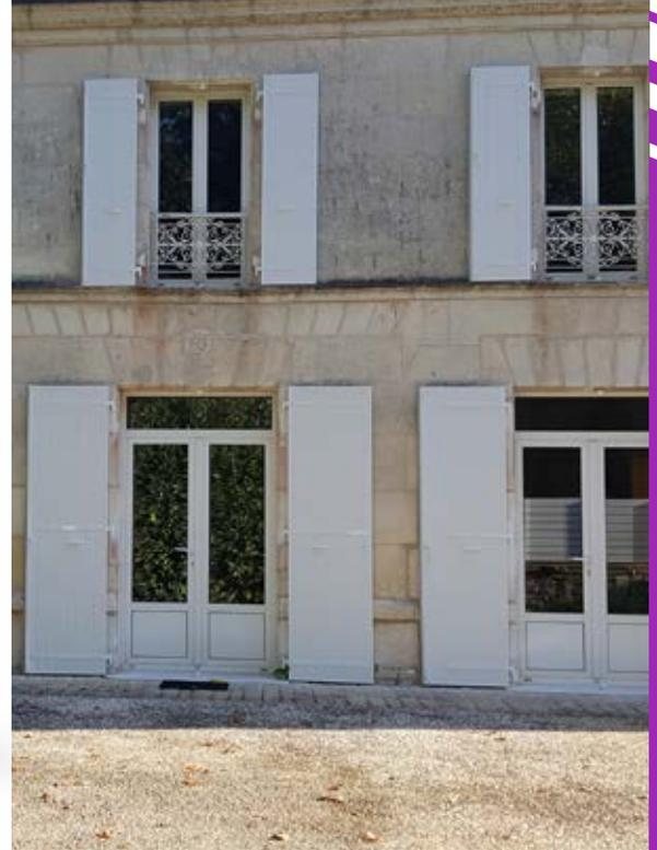
Volets en configuration Contre-pentures et ferrage
