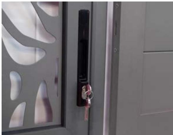
■ Serrure pour coulissant en option compatible uniquement avec le cadre mécanique
